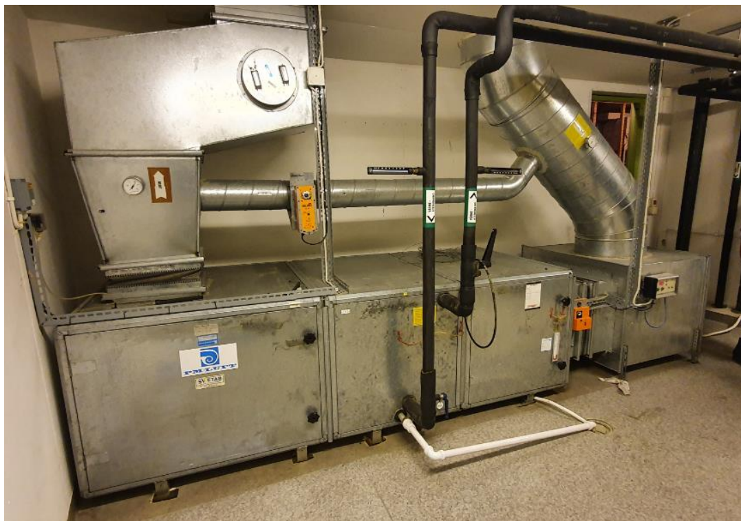
Bild 5 Frånluftsaggregat FA3
